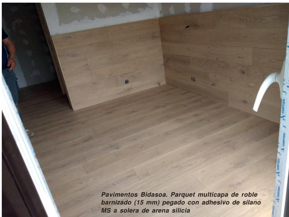
*Pavimentos Bidasoa. Parquet multicapa de roble barnizado (15 mm) pegado con adhesivo de silano MS a solera de arena silicia*
